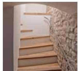
Die traditionellen Bauteile werden respektvoll behandelt. Altes wird erhalten und steht mit neu eingefügten Bauteilen in einem bewussten Kontrast.
