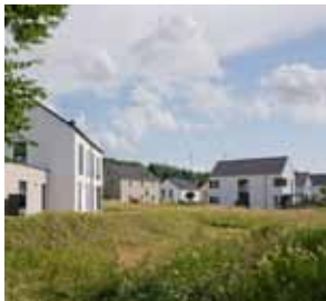
Dieser Entwicklungsprozess von der Idee des Bebauungsplans bis hin zu der Fertigstellung von Wohngebäuden als harmonische Gesamtheit ist beispielgebend für Ortsgemeinden.
