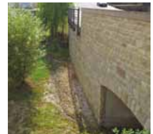
Kernstück der fertigen Ortsdurchfahrt ist ein Brückenbauwerk, welches nicht als Standardlösung, sondern mit heimischem Material in Kalkbruchsteinmauerwerk ausgeführt wurde und heute erlebbar über die Bachmulde führt.
