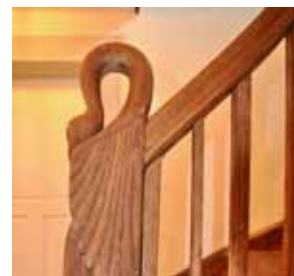
Der Antritt der erhaltenen Treppe mit eingeschnitztem Kopf eines Schwans im Handlauf.
