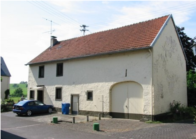
Foto oben: Kleinbäuerliches Trierer Quereinhaus, Zustand vor der Modernisierung des Anwesens mit Wohn-, Stall- und Scheunenteil unter einem Dach.
