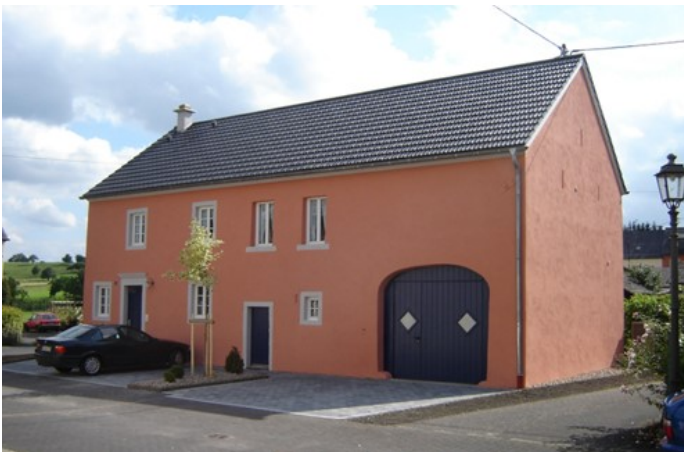
Foto unten: Gebäude nach der erfolgtem Umbau und Sanierung. Die Altbausubstanz einschl. der bestehenden Fenster- und Türöffnungen wurde weitestgehend erhalten. Neue Fensteröffnungen oberhalb des ehem. Stalles wurden bewusst und gestalterisch erkennbar abgesetzt. Die Hoffläche vor dem Haus wurde mittels Grünfläche und Hausbaum gliedert.
