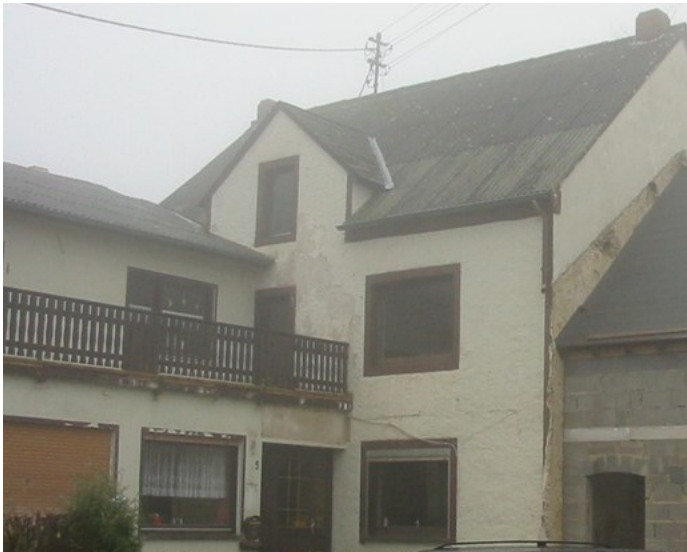
Foto oben: Situation vor dem Umbau. Die Fassade des Altbaues wurde durch den späteren Anbau (links) und die Veränderung der Fensterformate sehr nachteilig verändert.
