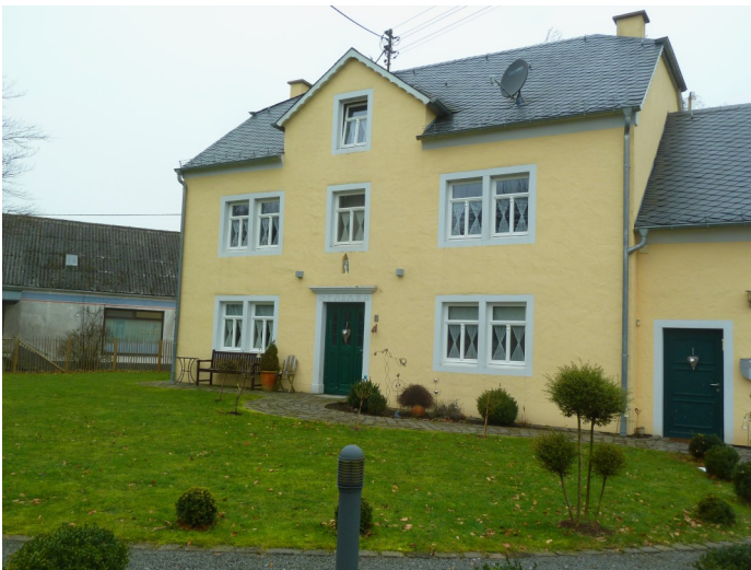
Foto unten: Modernisierter und wiederhergestellter Altbau nach Modernisierung und Abbruch des Anbaues. Gestalterisch trägt das Gebäude heute zu einer hohen Aufwertung des Ortsbildes bei.
